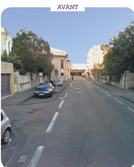
Les bandes cyclables ne respectant pas les recommandations du CEREMA
