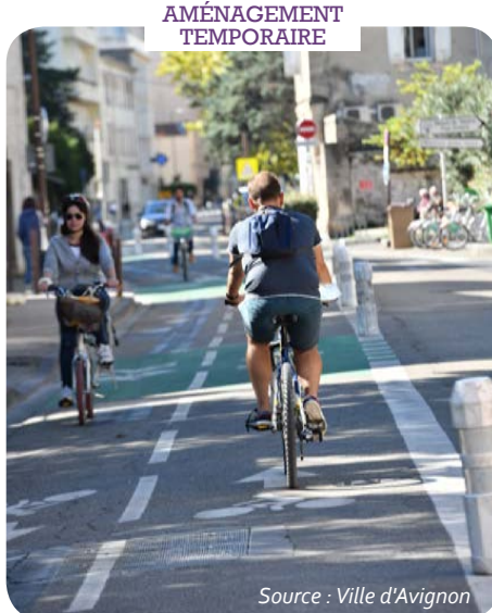
Marquage au sol et mobilier temporaire
